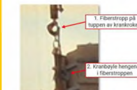
Bildet er tatt 15 min før hendelsen og man kan se fiberstroppen (1) med kranbøylene (2) henge på tuppen av kroken, utenfor låsemekanismen.
